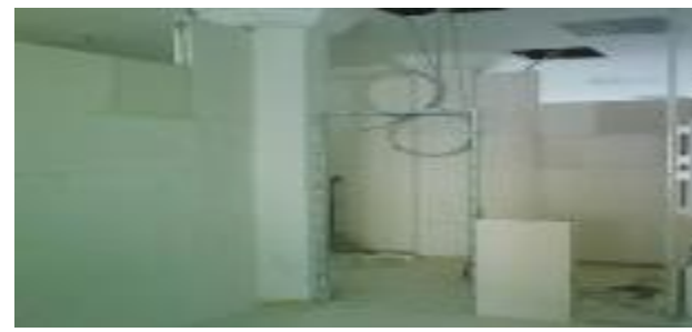
Figure 31 & 32 : Plaques de plâtre fibrée (gauche) et plaques de plâtre cartonnée (droite) produites à partir des gisements de plâtre en Tunisie
