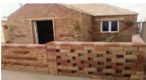
Figure 29 & 30 : Briques de terre compressée utilisées dans des constructions à Tozeur
