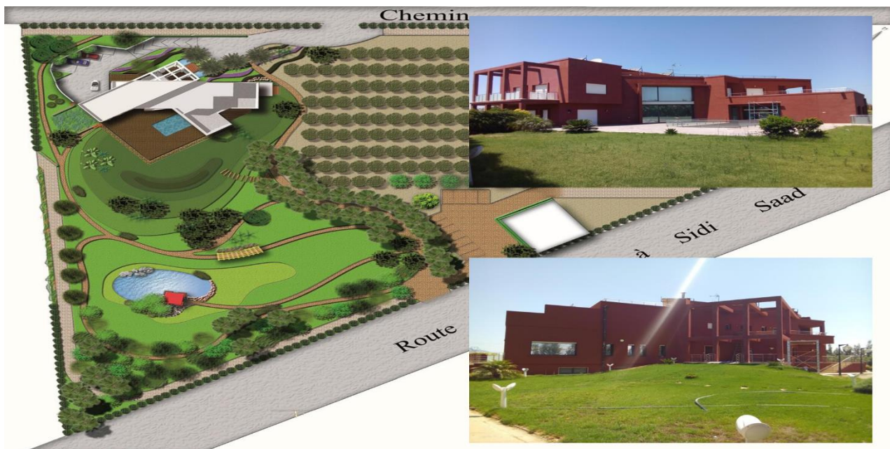
Figure 24 : Villa autonome à Mornague, utilisant des parpaing isolés et un puit canadien
